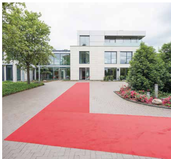
DER IM SOMMER 2017 FERTIG GESTELLTE ANBAU BIETET RAUM FÜR 18 MITARBEITER UND DREI BESPICHRUNGSRÄUME
